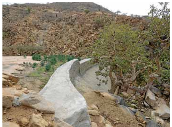
Die Dammkrone wurde erhöht, um mehr Wasser zu speichern.
